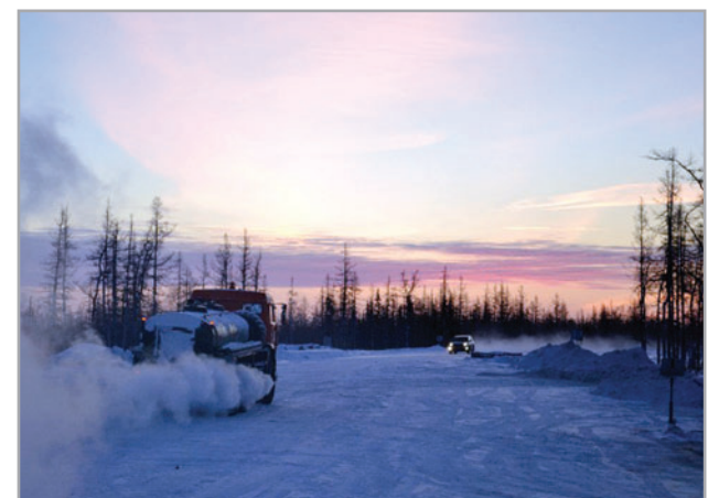
На стройке трассы «Надым–Салехард»
