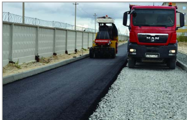
Уплотнение уложенного нижнего слоя асфальтобетонного покрытия катком на пневмоколесном ходу
