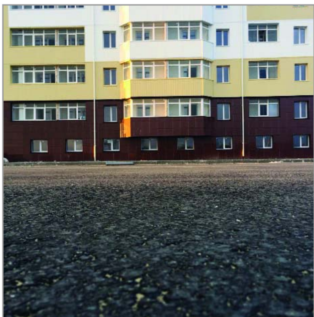
Вид со стороны парковочной зоны на жилой дом
