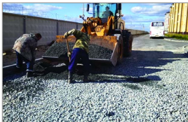
Расклиновка щебеночного основания мелкой фракцией перед устройством асфальтобетонного покрытия
