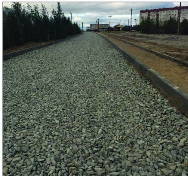
Щебеночное основание проезжей части
