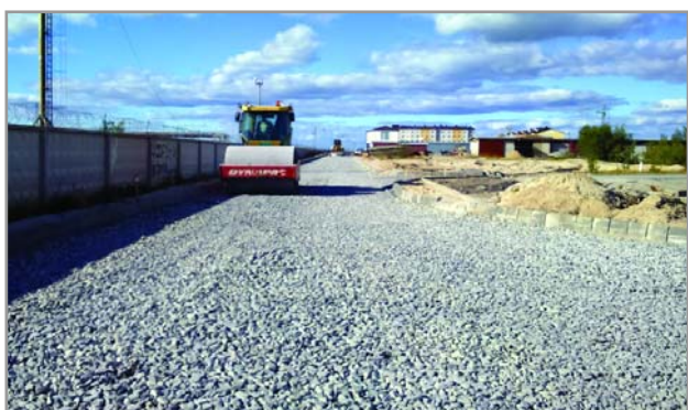
Уплотнение щебеночного основания катком
