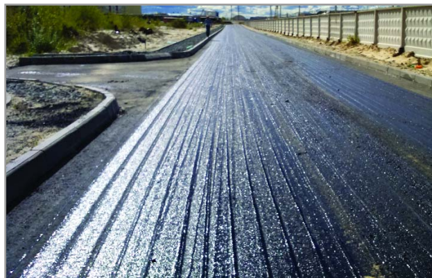
Проливка битумом нижнего слоя асфальтобетонного покрытия перед укладкой геосетки
