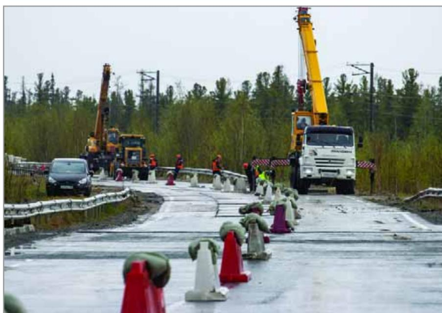
Следующий этап — асфальтирование. По проекту здесь предусмотрена укладка асфальтобетонного покрытия в три слоя. Выравнивающий слой из черного щебня на некоторых участках достиг 30-40 см. Затем следует слой из крупнозернистого асфальтобетона, а завершает слой покрытия щебеночно-мастичный асфальт. В сезон было выполнено больше половины объемов — это более 17 км.
